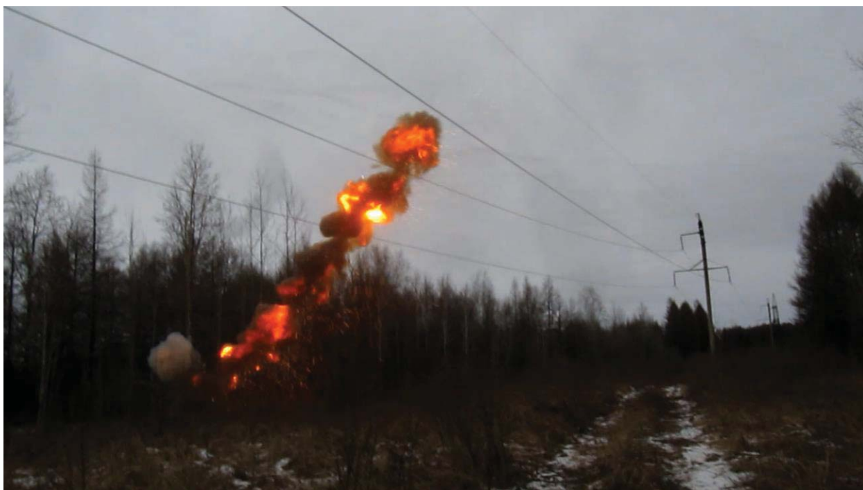
Рис. 5.19. КЗ ф. «А» на землю в пролетах опор №2 - №3 отпайки на ПС Хвойная (Окончание)
